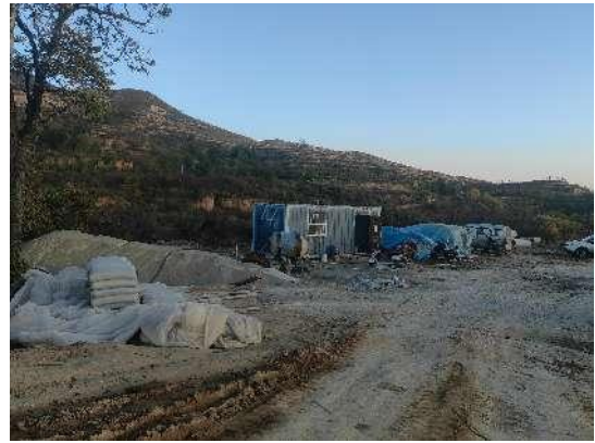
施工生产场地现状
